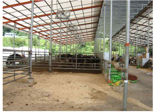
<그림2> 축사 내 대형 선풍기 설치
