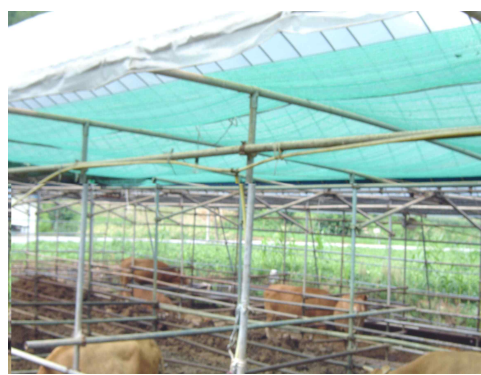
<그림8> 축사내 차광막 설치
