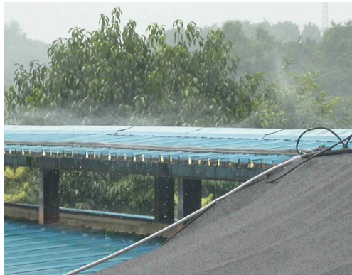
<그림5> 돈사지붕 스프링클러 설치
