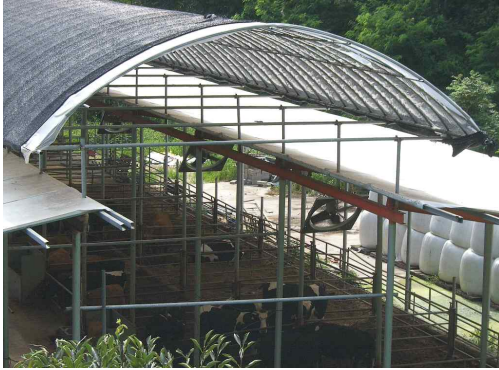
<그림1> 비가림축사 내 차광망 설치
